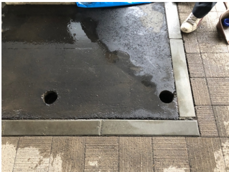
①アスファルト2カ所穴開け 作業時間:約30分
